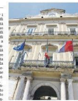
Intervento, che come già sottolineato è coperto da un investimento complessivo di 7,2 milioni di euro, include le seguenti diverse voci: contabilità di circa 5,5 milioni di euro destinati ai lavori edili (tetti e interni).
