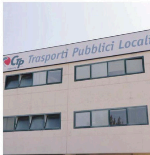
La sede del Consorzio Trasporto pubblico di via del Tratturello Tarantino al quartiere Paolo VI sarà la base logistica per il corso di formazione destinati ai meccanici dell'azienda
